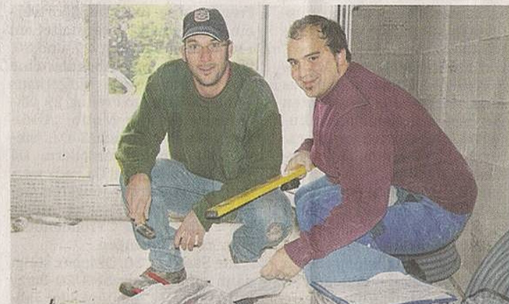
Heiko Kölling (links) und Timo Bauer vom Turn- und Sportverein Fortuna helfen mit beim Innenausbau des neuen Vereinsheimes am Saarburger Kammerforst.
